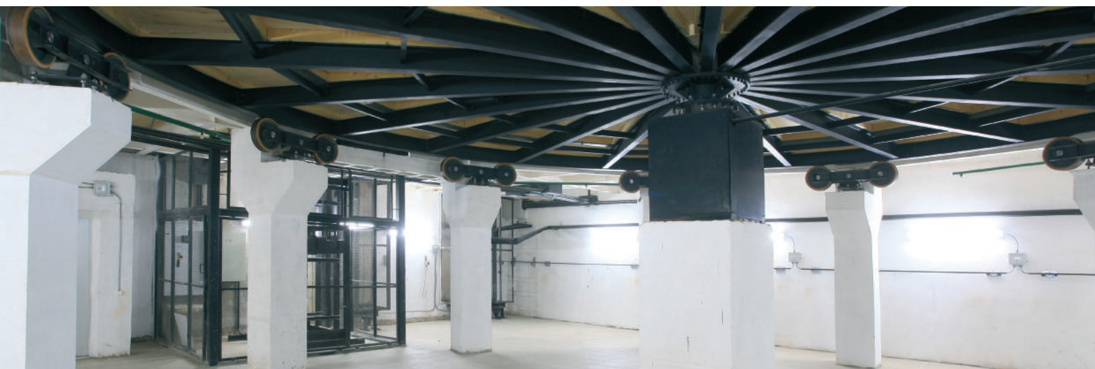
Поворотный круг дискового типа
