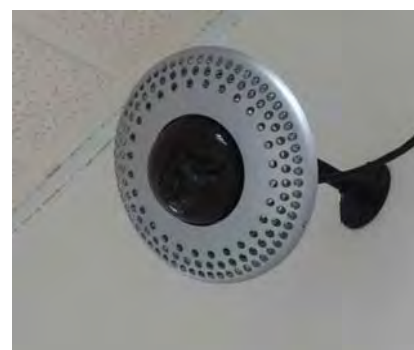
Рис. 3.27. Монтаж цифрового инфракрасного трансивера HCS-5300TD на стене
